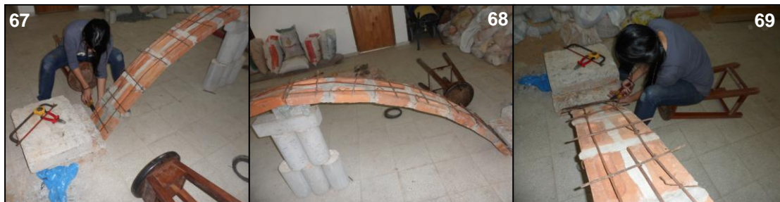
Gráficos 67,68 y 69: Proceso de envarillado superior para recibir al hormigón
