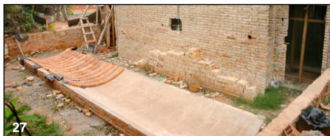
Gráfico 27: Cimbra de long. 8m. realizada para Capilla. Con capacidad para 25 dovelas en simultáneo
