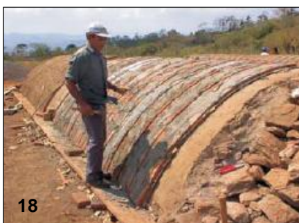
Gráfico 17: Vista del Barrio. Gráfico 18: Elaboración del molde “burrito” para fabricación de dovelas. Fuente: Compilado de Fotos. Silvio Ríos.
