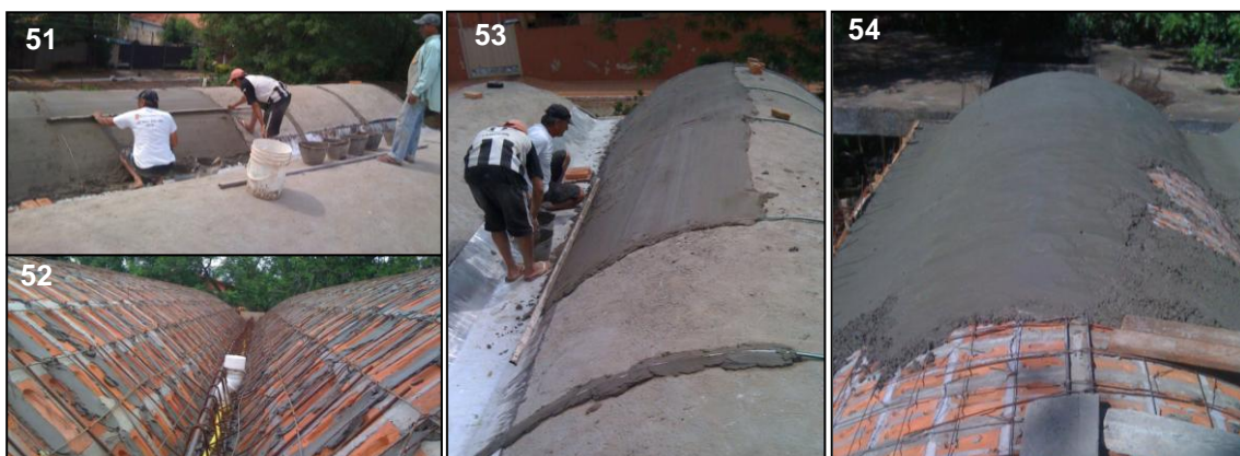
Gráficos 51 y 53: Proceso de enrase de la capa de terminación. Gráfico 52: Techo con parrilla superior antes del cargado. Gráfico 54: Proceso de cargado de H°
