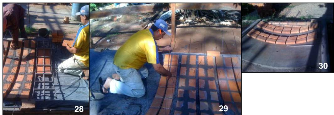
Gráfico 28: Plantilla para colocación de ladrillos.
