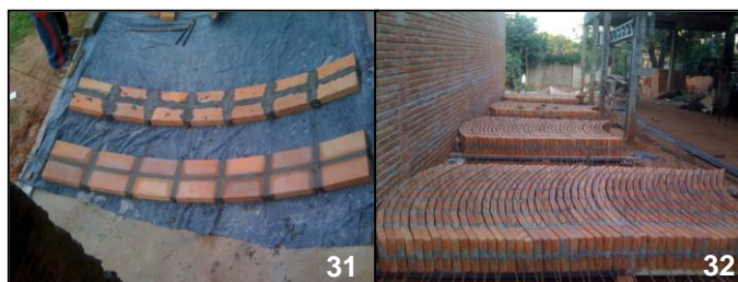
Gráfico 31: Dovela con mezcla fresca, y dovela con terminación.
