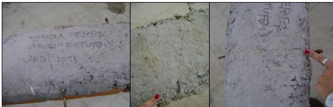
Gráficos que demuestran las rajaduras aparecidas durante los 4 meses. Fuente: Imágenes de elaboración propia.
