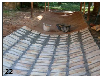
Gráfico 21 Imagen de molde “cimbra” enrasada con la pieza de madera Gráfico 22: Cimbra con ladrillos. Fuente: Imágenes provistas por el Arq. Yago Garcia.
