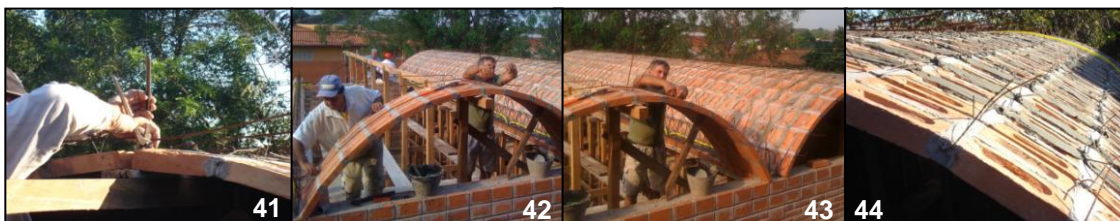
Gráfico 41: Varillas de vértice que son unidas mediante alambres.
