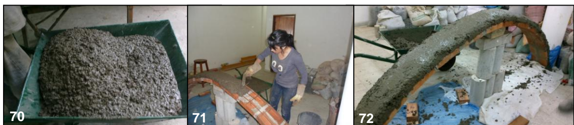
Gráficos 70,71 y 72: Proceso de cargado del hormigón. Fuente: Imágenes de elaboración propia.
