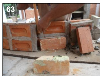
Gráfico 59: Momento de curado de dovelas. Gráficos 60 Y 61: Dovela con ladrillos remendados. Fuente: Imágenes de elaboración propia.
