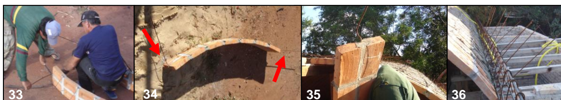
Gráfico 33: Momento en que se tuercen las varillas bigotes.
