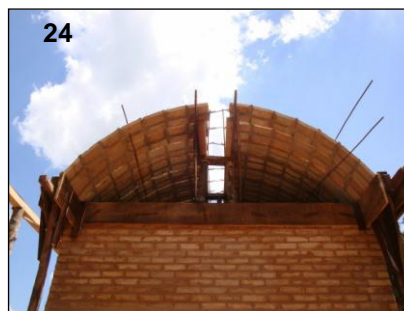
Gráficos 23 Y 24: Bóvedas compuestas por 2 dovelas en bloque Dormitorio. Fuente: Imágenes provistas por el Arq. Yago Garcia.
