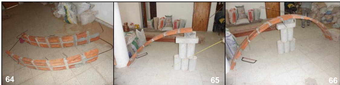
Gráficos 64,65 y 66: Proceso de conformación del arco.
