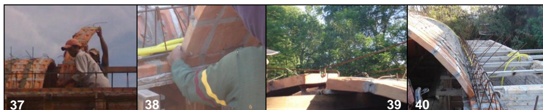
Gráfico 37: Montaje de dovela apoyo y vértice.
