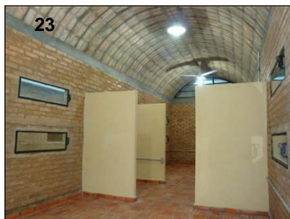
Gráficos 23 Y 24: Bóvedas compuestas por 2 dovelas en bloque Dormitorio. Fuente: Imágenes provistas por el Arq. Yago Garcia.
