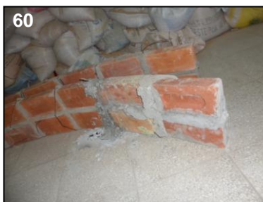
Gráfico 59: Momento de curado de dovelas. Gráficos 60 Y 61: Dovela con ladrillos remendados. Fuente: Imágenes de elaboración propia.
